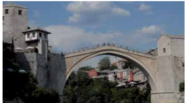
Mostar, Bosnië. De 'Stari Most' (oude brug) over de Neretva-rivier. Gebouwd in 1566 en vernietigd in 1993. Terug opgebouwd door de Europese Unie onder supervisie van Unesco. (foto: Eddie A.)
